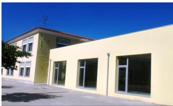
Fig. 12 – Obras de requalificação da EB1/JI de Góis
