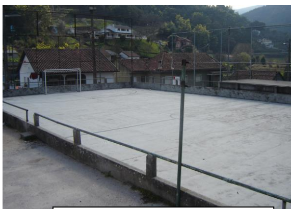
Figura 51 - Polidesportivo de Ponte do Sótão
