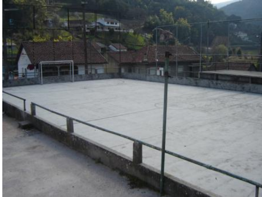
Fig. 20 - Polidesportivo de Ponte do Sótão
