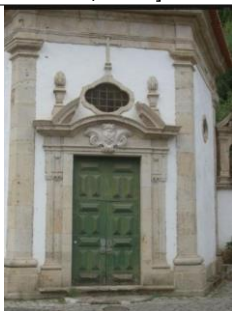
Figura 01 - Capela de S. Sebastião: fachada principal
