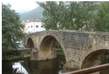
Figura 02 - Ponte sobre o rio Ceira
